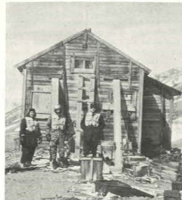
Foto reciente de la casa de Nordenskjöld en Cerro Nevado poco antes de iniciarse los trabajos de restauración a cargo de nuestro país
