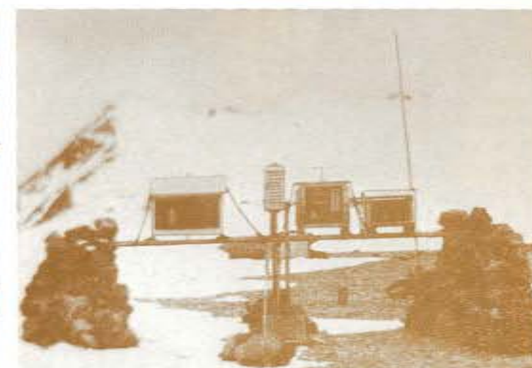
Instrumental meteorológico para los registros y las observaciones en superficie instalados por Mossman en el istmo de la isla Laurie, Orcadas del Sur. 1904
