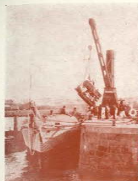
La grúa levanta una máquina alternativa para la "Uruguay", antes fue del destructor "Santa Fe".
