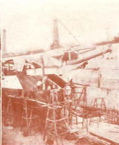
En la proa, ya forrada con una tablarón especial, se colocan refuerzos de hierro para desafiar el hielo.
