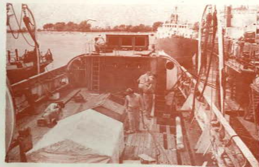
Los calafateadores trabajan sobre la tablarón de la cubierta pocos días antes de que la "Uruguay" regrese a su apostadero de honor.
