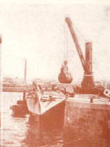
Montaje de una nueva y más potente caldera, la original era demasiado pequeña y estaba fuera de servicio.
