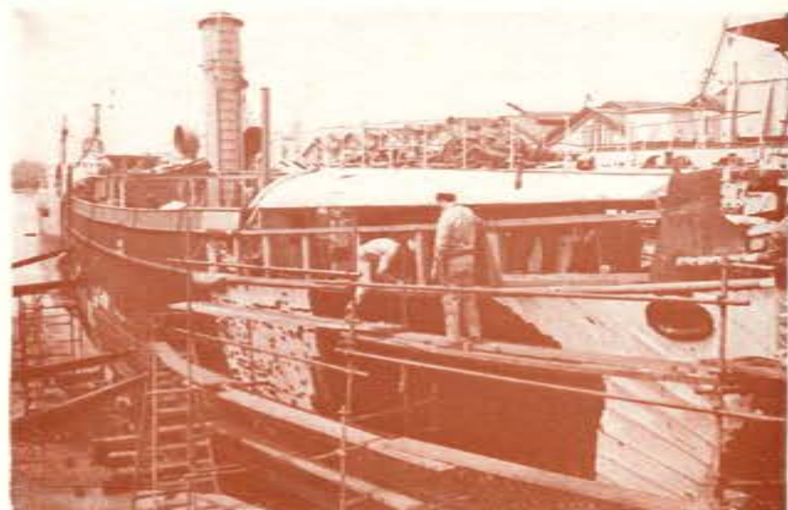
Trabajos en la proa durante la última reparación de la corbeta en el año 1974 que estuvo bajo la dirección del capitán de navío Hugo Luis Dietrich.
