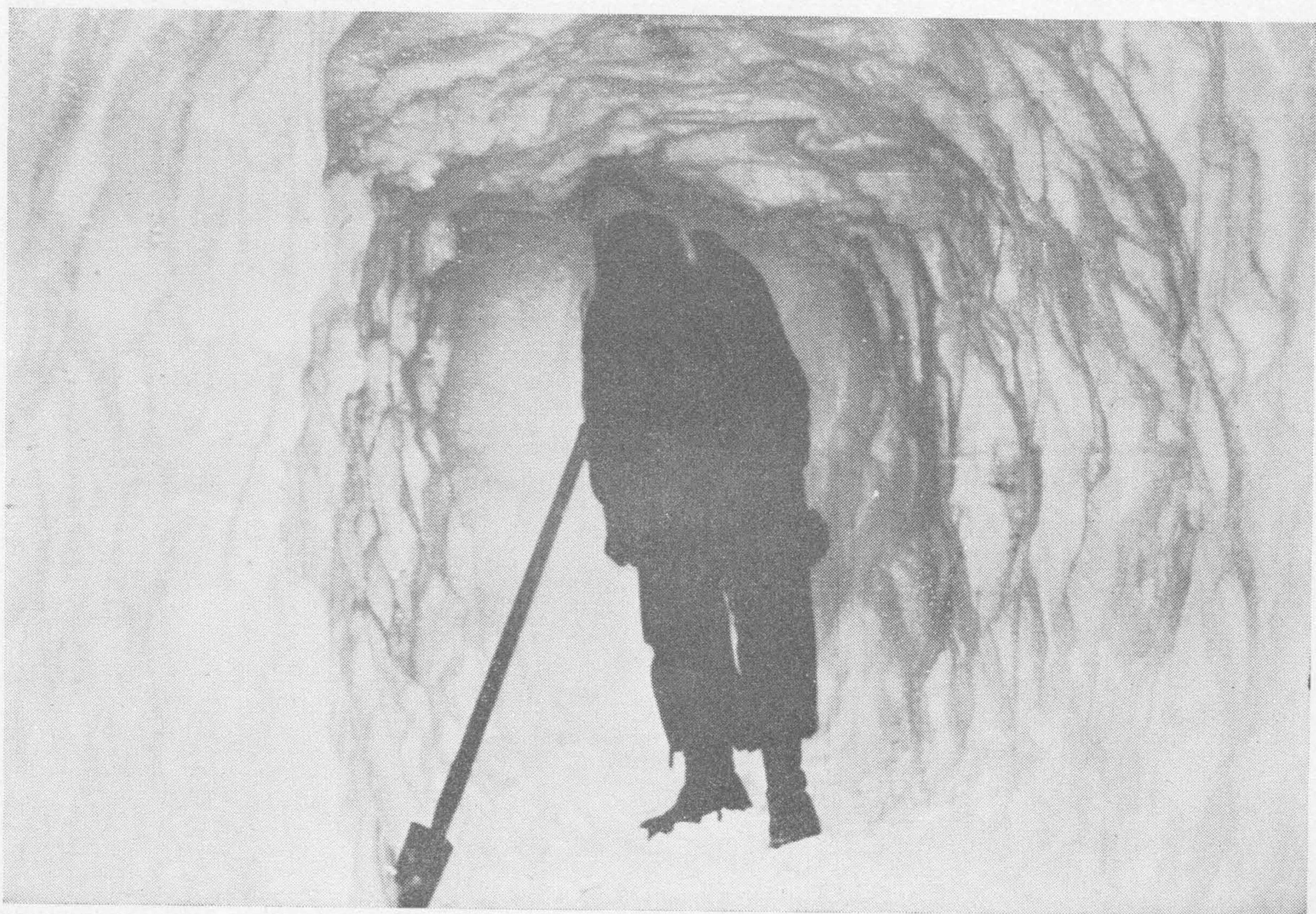
Túnel en el hielo para obtener agua por derretimiento en la base General Belgrano. (Foto del Instituto Antártico Argentino catalogada AN-1400)
