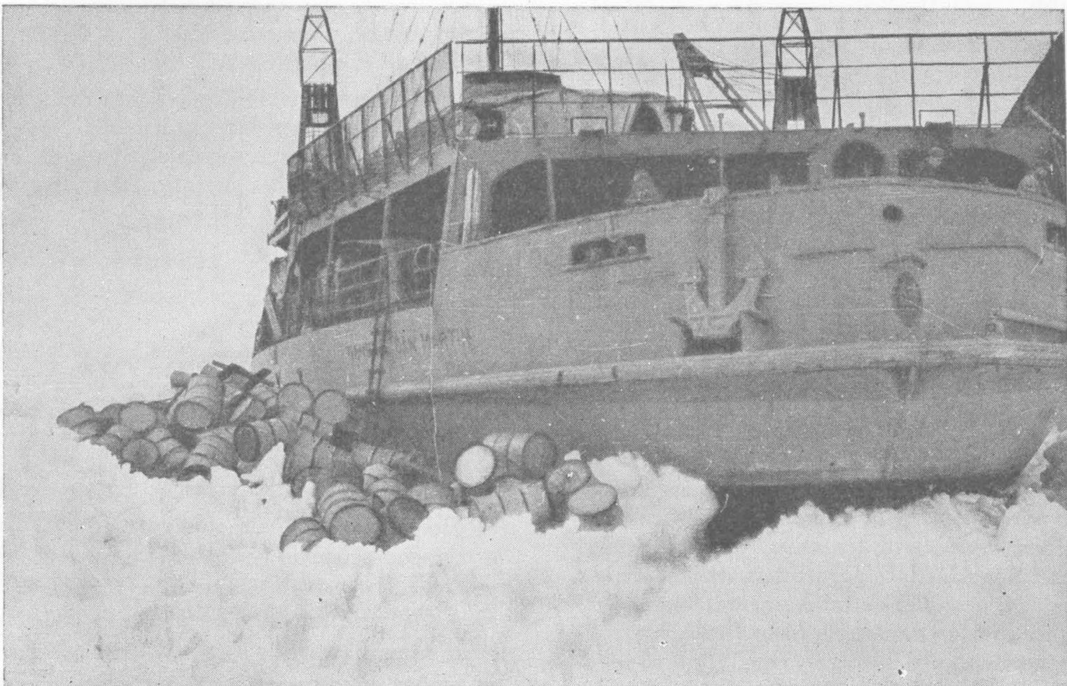
El rompehielos "General San Martín" atrapado entre los hielos en bahía Margarita. En la fotografía se ve parte de la carga que hubo de ser abandonada a los efectos de levantar su línea de flotación. (Foto del Instituto Antártico Argentino, catalogada BN 258).
